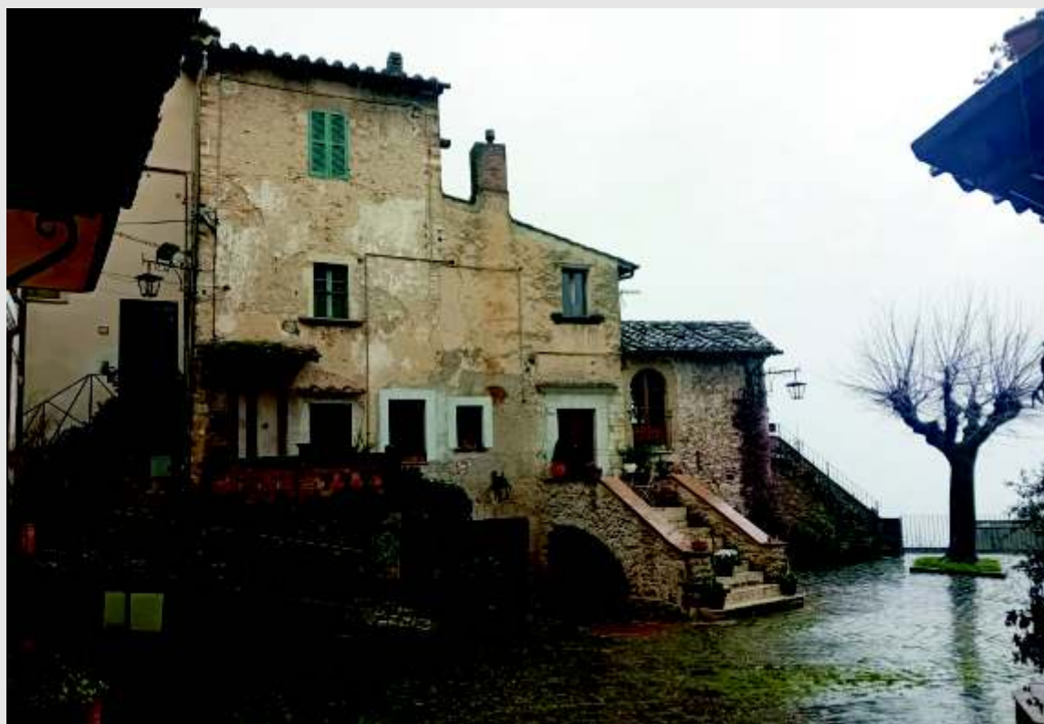
FOTO 8: Due aspetti di piazza della Torre. Il “quartiere dei lombardi” ovvero “le case dei lombardi” individuate nel centro storico di Stroncone, poste a ridosso della cinta muraria e vicino ai beni della Chiesa di San Nicola.
